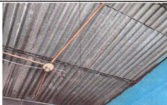
Foto 6: En la imagen se muestra como el sistema eléctrico ya está en mal estado inclusive los cables ya están quemados
