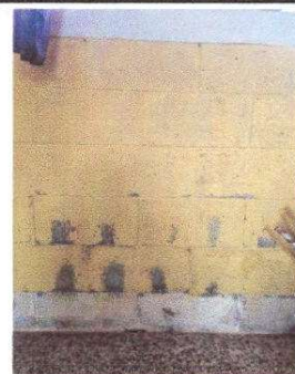
Foto 4: En estas Fotografías se muestra como la pintura se esta quitando de la pared
