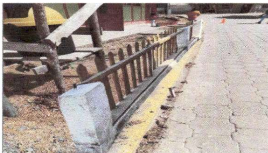
Foto 5: En esta fotografía se evidencia que el muro es de tabla pero es necesario cambiarlo a barandas de metal por que ya está deteriorado por la lluvia
