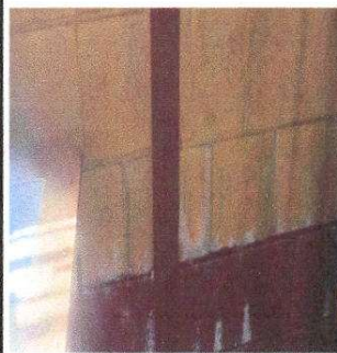
Foto 4: En estas Fotografías se muestra como la pintura se esta quitando de la pared
